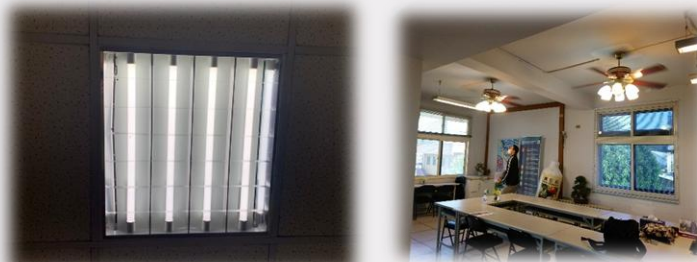
汰換傳統燈具為LED節能燈具
