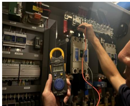
送電、ACB相序測試
